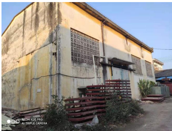
东面的光华电力公司电器仓库
