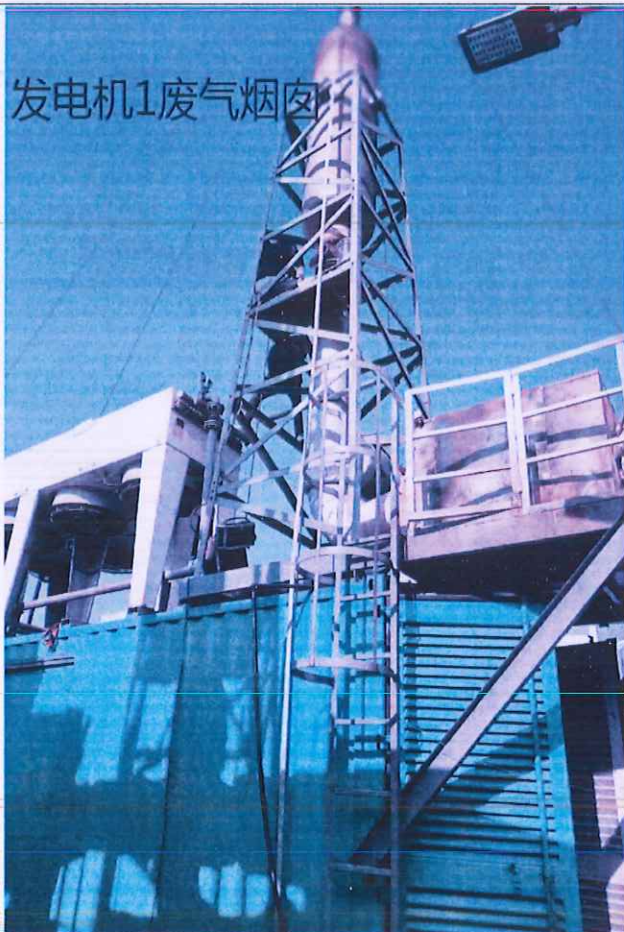
2#发电机废气排气筒及采样
