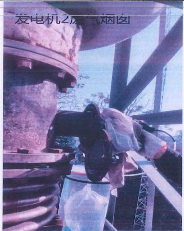
2#发电机废气排气筒及采样
